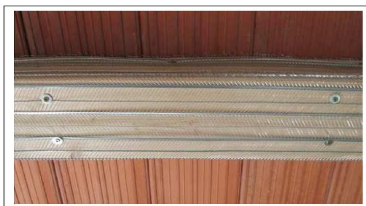
Abbildung A.7.3: Detail des Streckgitters.
