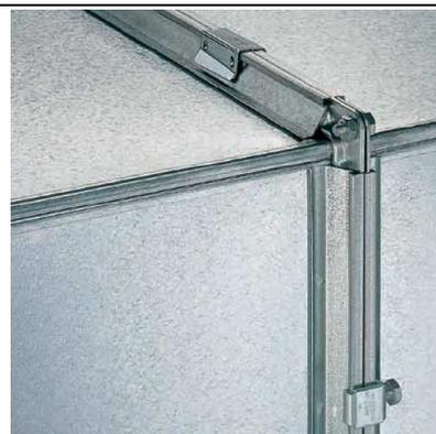
**Abbildung A.6.1:** Abhängungssystem des Kanals und METU-System-Querverbindung.
