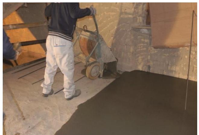
Figura 6.4: Vertido de mortero Planitop HPC Floor.
