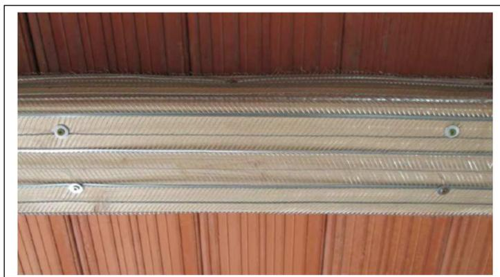
**Figura A.7.3:** Detalhe da fixação da malha.
