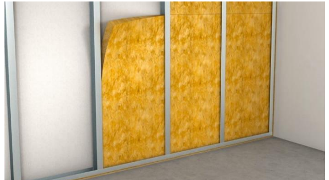
Figura 6.5: Montaje del aislante.
