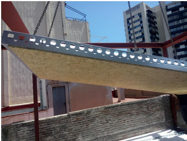
Figura 4.2: Manipulación de prelosa del sistema SES™.
