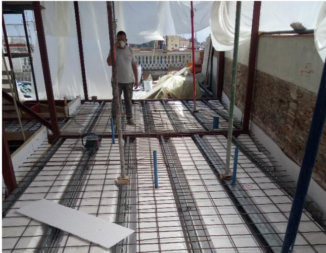
Figura 7.4: Disposición de armaduras en las prelosas.
