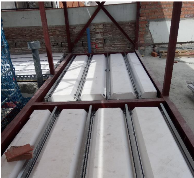
Figura 7.2: Prelosas apoyadas permanentemente sobre estructura metálica.
