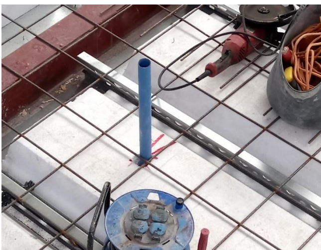
Figura 7.1: Paso de conductos verticales a través de la prelosa.
