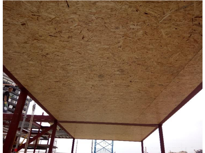
Figura 7.3: Vista inferior del forjado con prelosas apoyadas sobre la estructura metálica.
