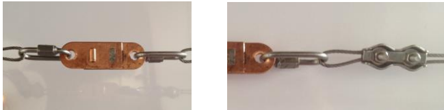
Figura 2.2: Instalación del fusible térmico en el recorrido (izquierda) y al final (derecha) de la línea de detección.
